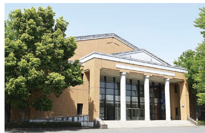
講堂兼総合体育館(プラザ40)
